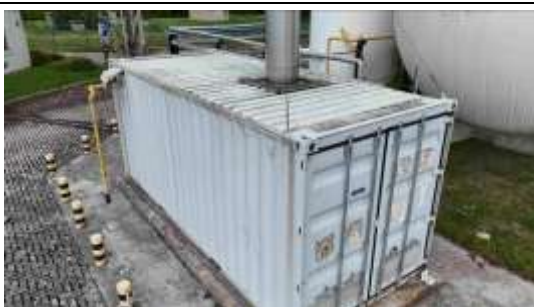
Uz zemes gabala ar kadastra apzīmējumu 1700 022 0112 atrodas inženiertehniskās iekārtas, kuras nav reģistrētas VZD sistēmas datos
